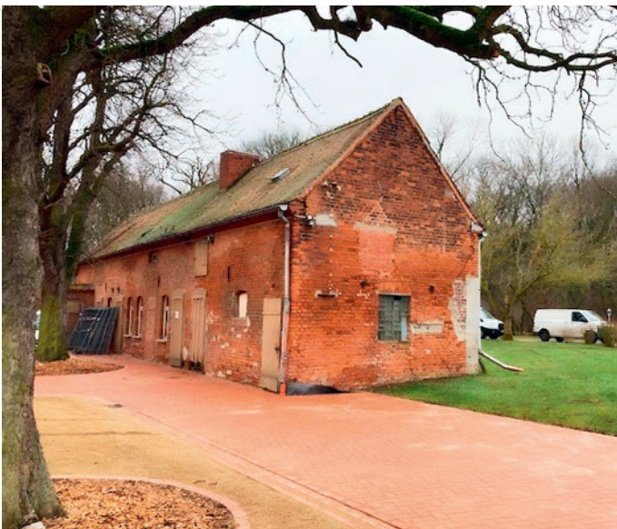
Das ehemalige ungenutzte Waschhaus auf dem Gelände der Samariterherberge Horburg im heutigen Zustand
